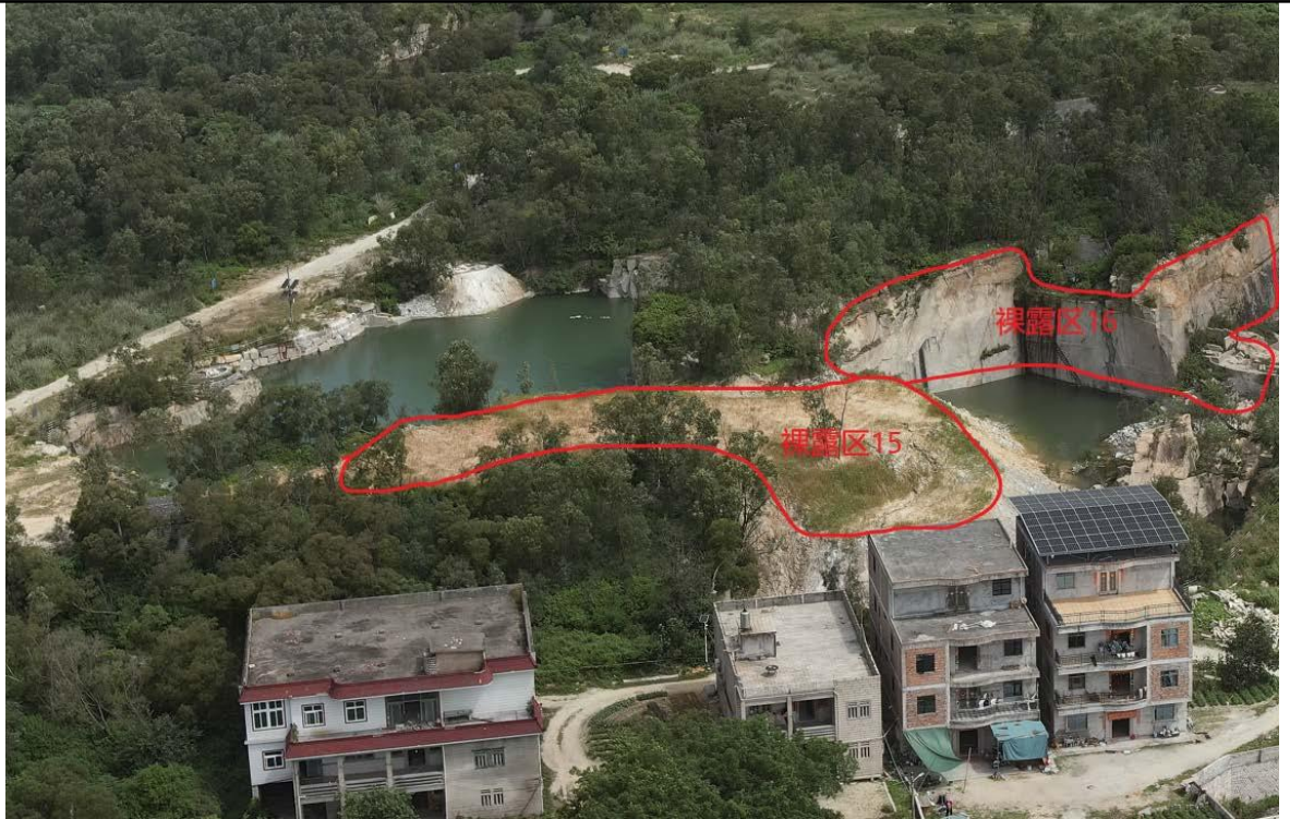
照片 3-1-11 裸露区II-15、II-16 现状（西北向拍摄）
