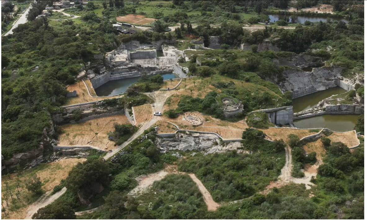
照片 3-5-42 已修复区现状（西北向拍摄）
