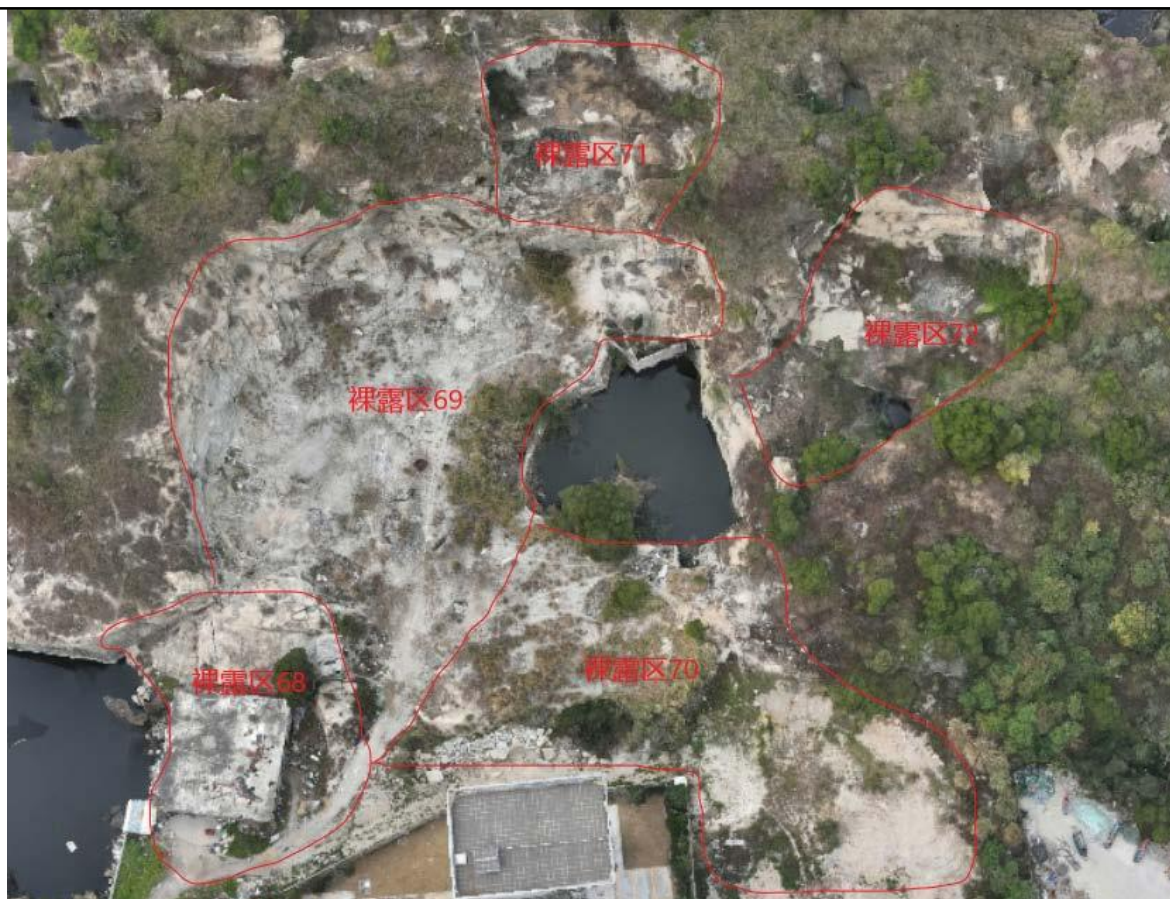
照片 3-5-48 裸露区现状（西北向拍摄）
