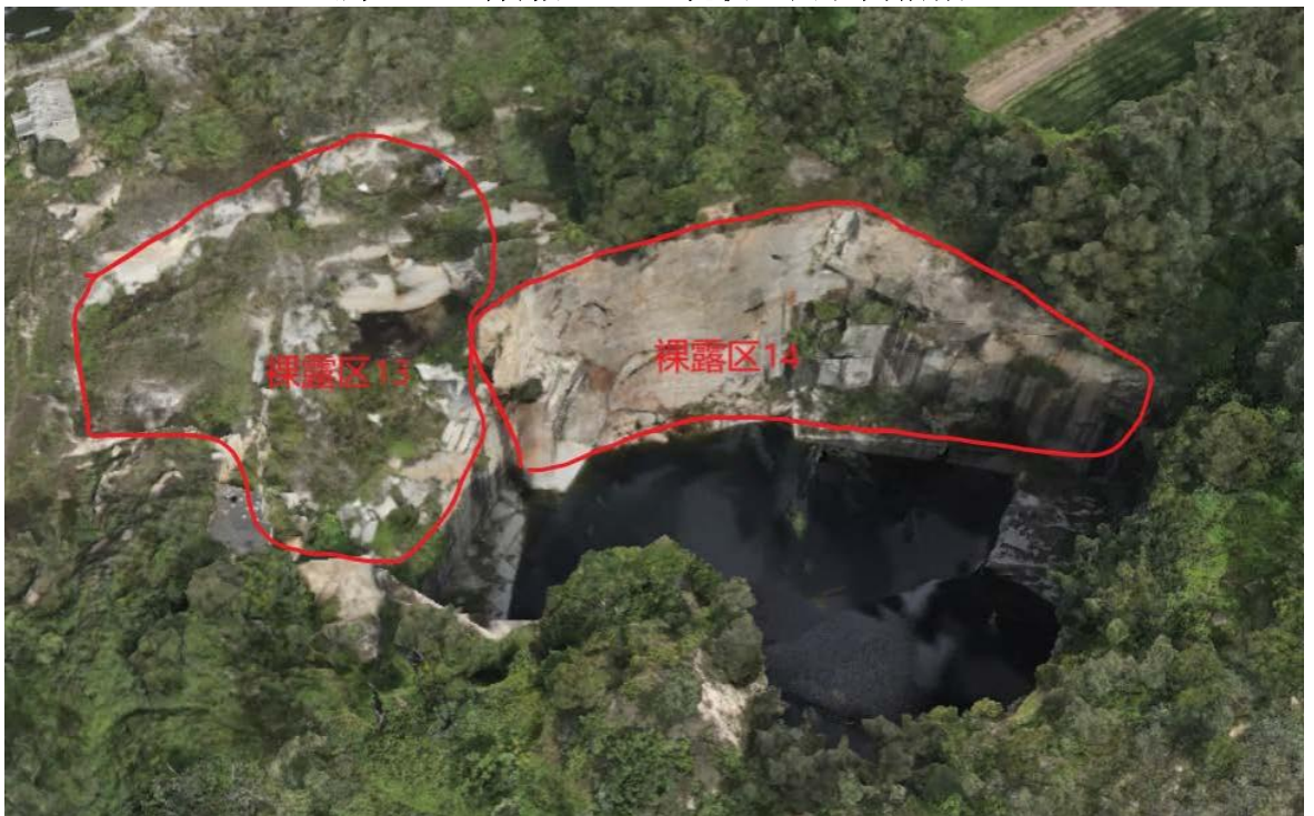
照片 3-1-10 裸露区II-13、II-14 现状（西北向拍摄）
