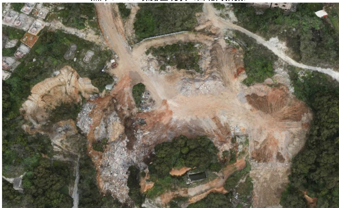
照片 3-4-31 裸露区II-46 现状（东南向拍摄）
