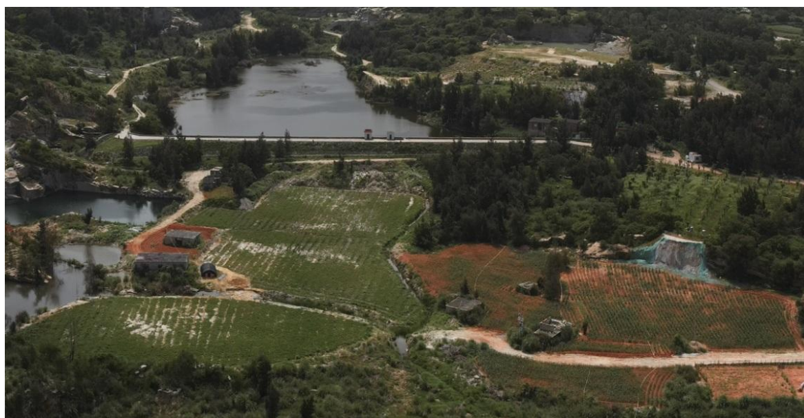
照片 3-3-27 已修复区现状（东南向拍摄）
