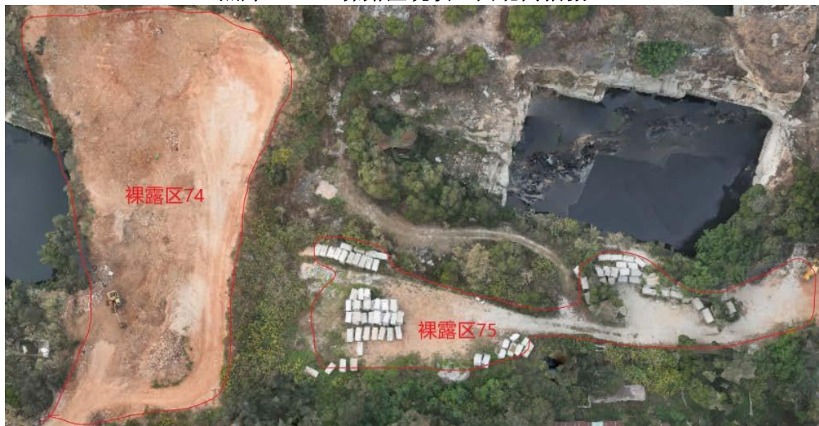
照片 3-5-49 裸露区现状（西北向拍摄）
