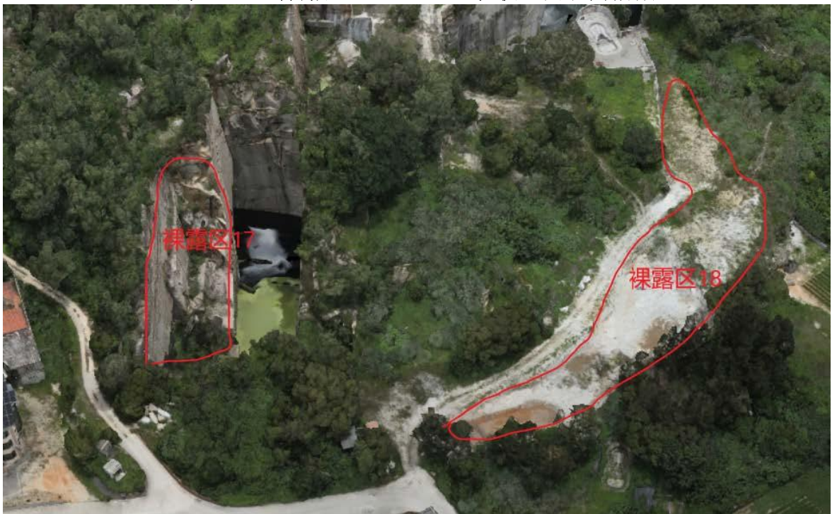
照片 3-1-12 裸露区II-17、II-18 现状（北向拍摄）
