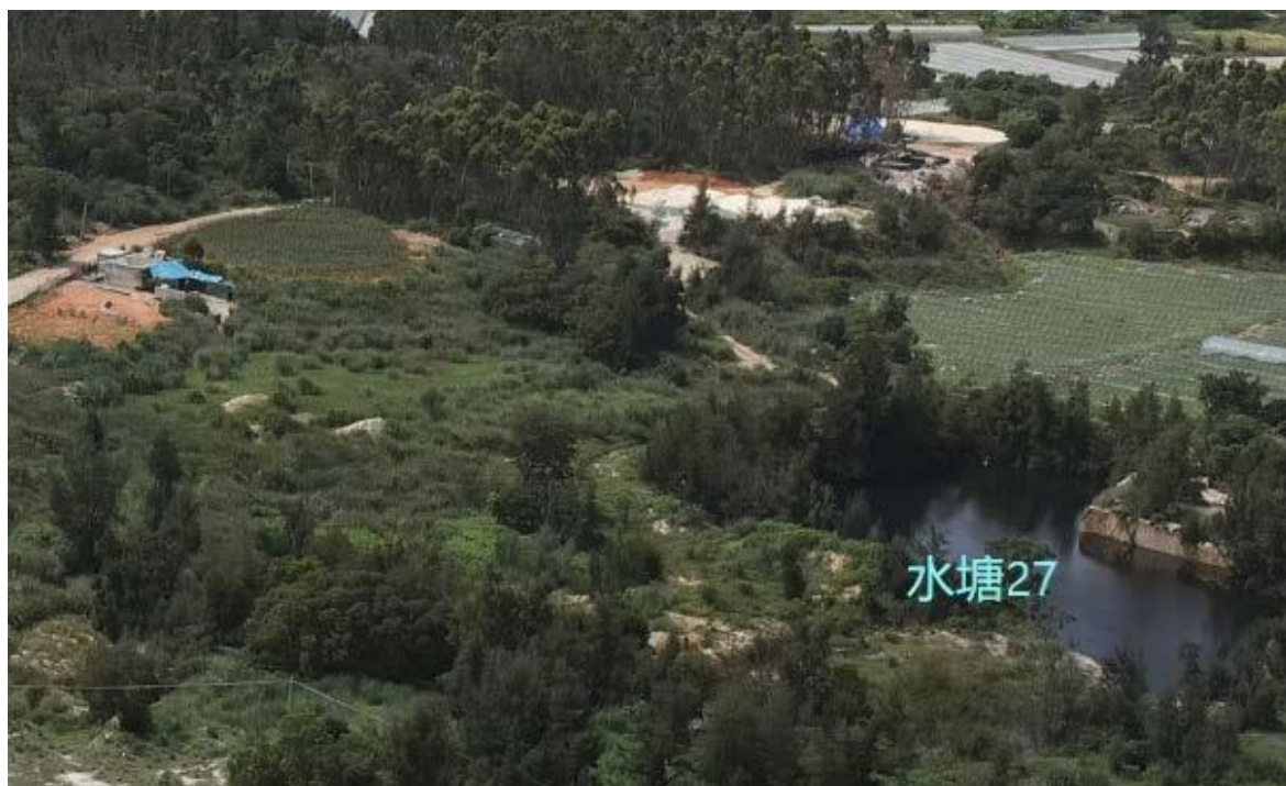
照片 3-3-18 水塘区现状（东南向拍摄）
