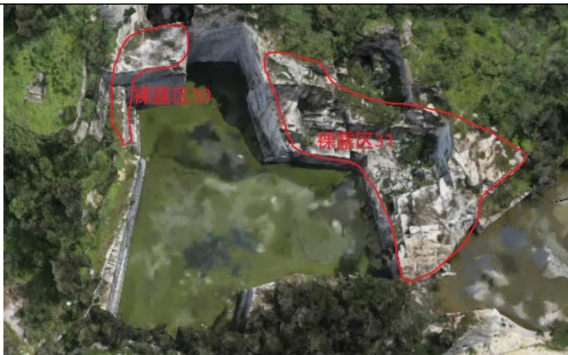
照片 3-3-26 裸露区II-30、II-31 现状（东北向拍摄）
