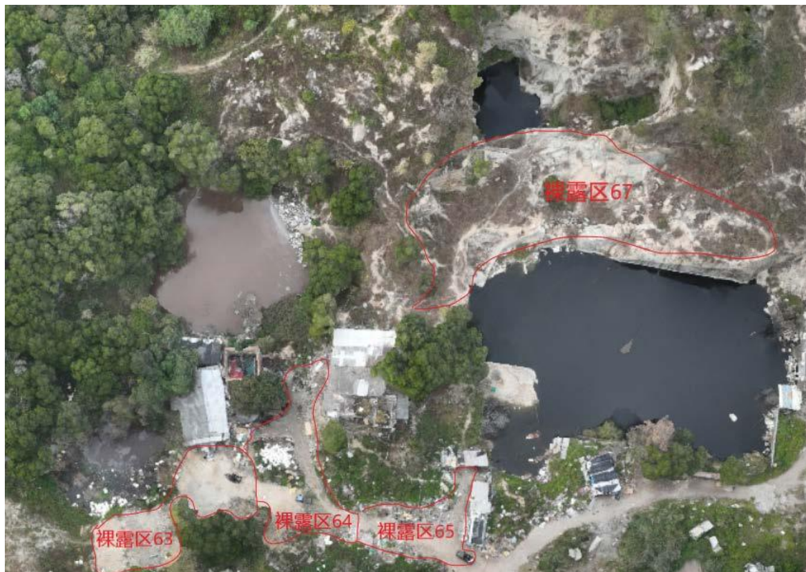
照片 3-5-47 裸露区现状（西北向拍摄）
