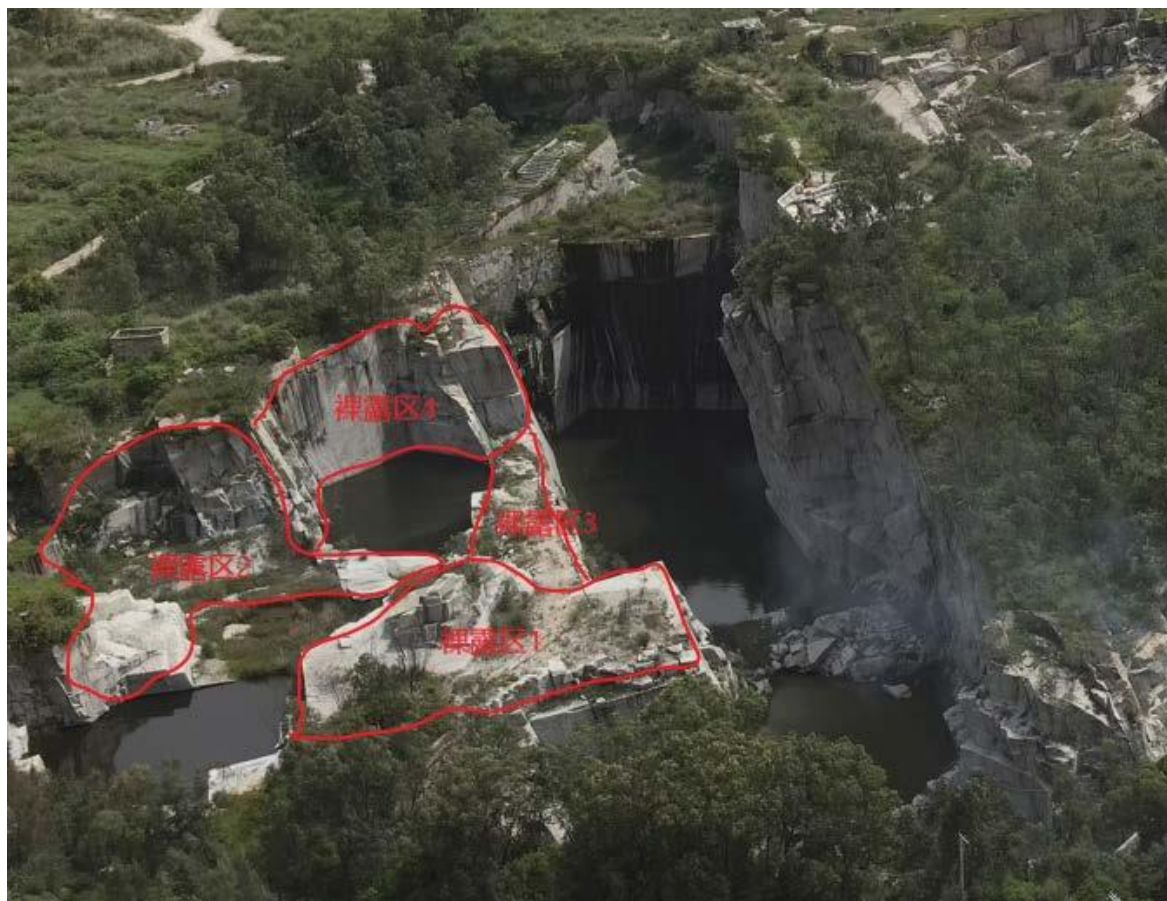
照片 3-1-6 裸露区II-1、II-2、II-3 和II-4 现状（西北向拍摄）
