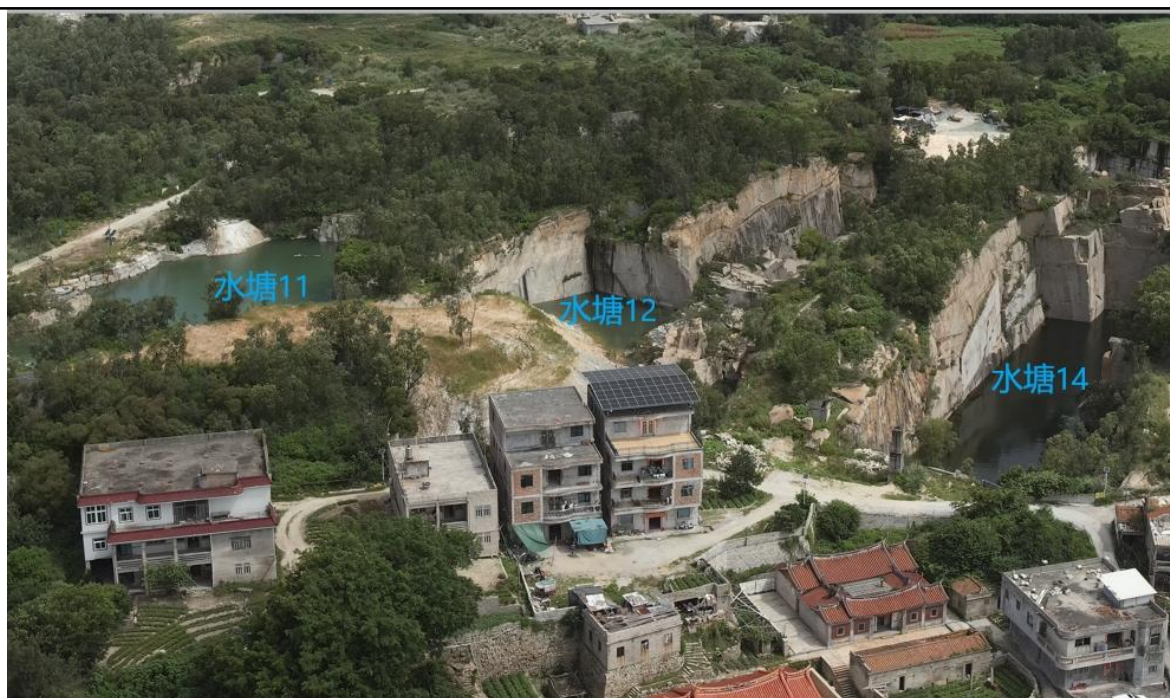
照片 3-1-4 水塘区现状（西北向拍摄）
