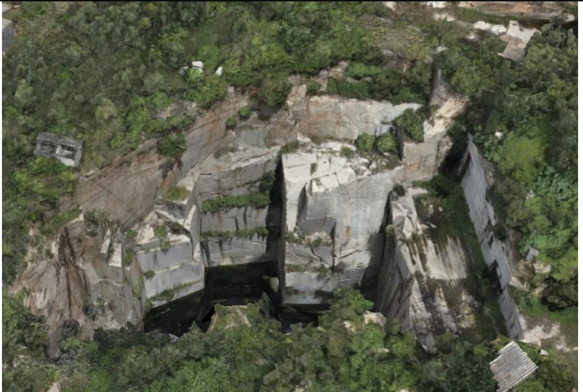
照片 3-1-9 裸露区II-12 现状（西北向拍摄）
