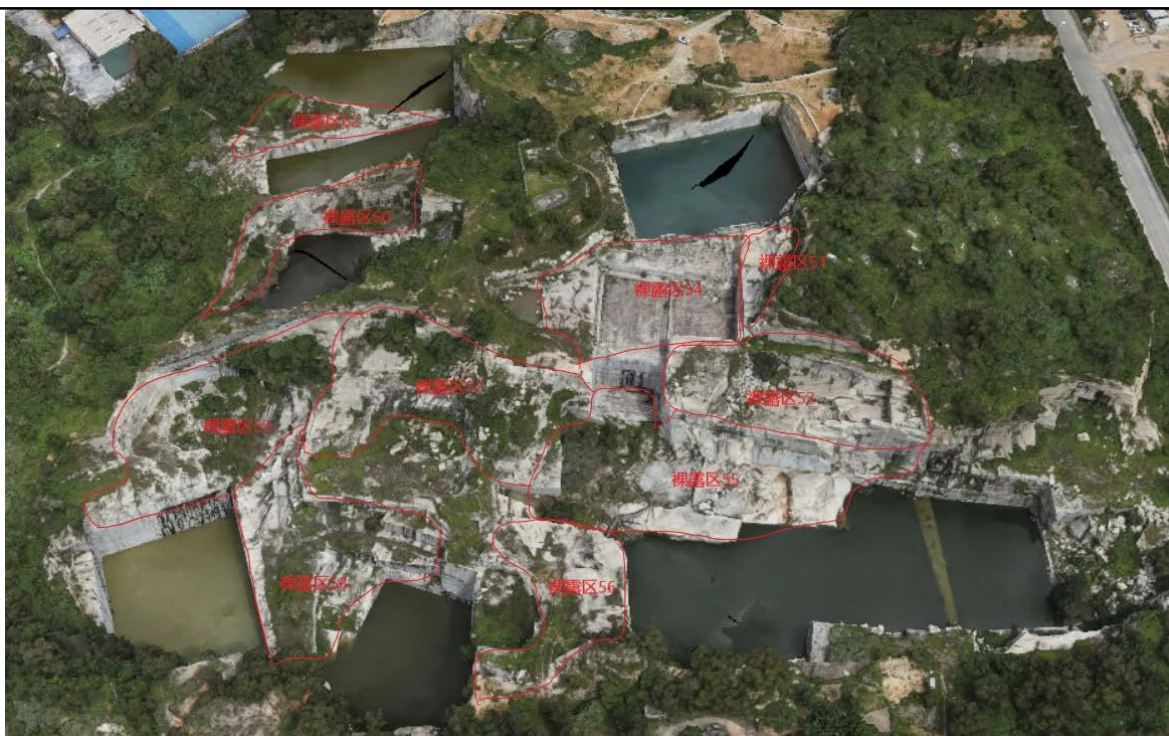
照片 3-5-40 裸露区现状（东北向拍摄）
