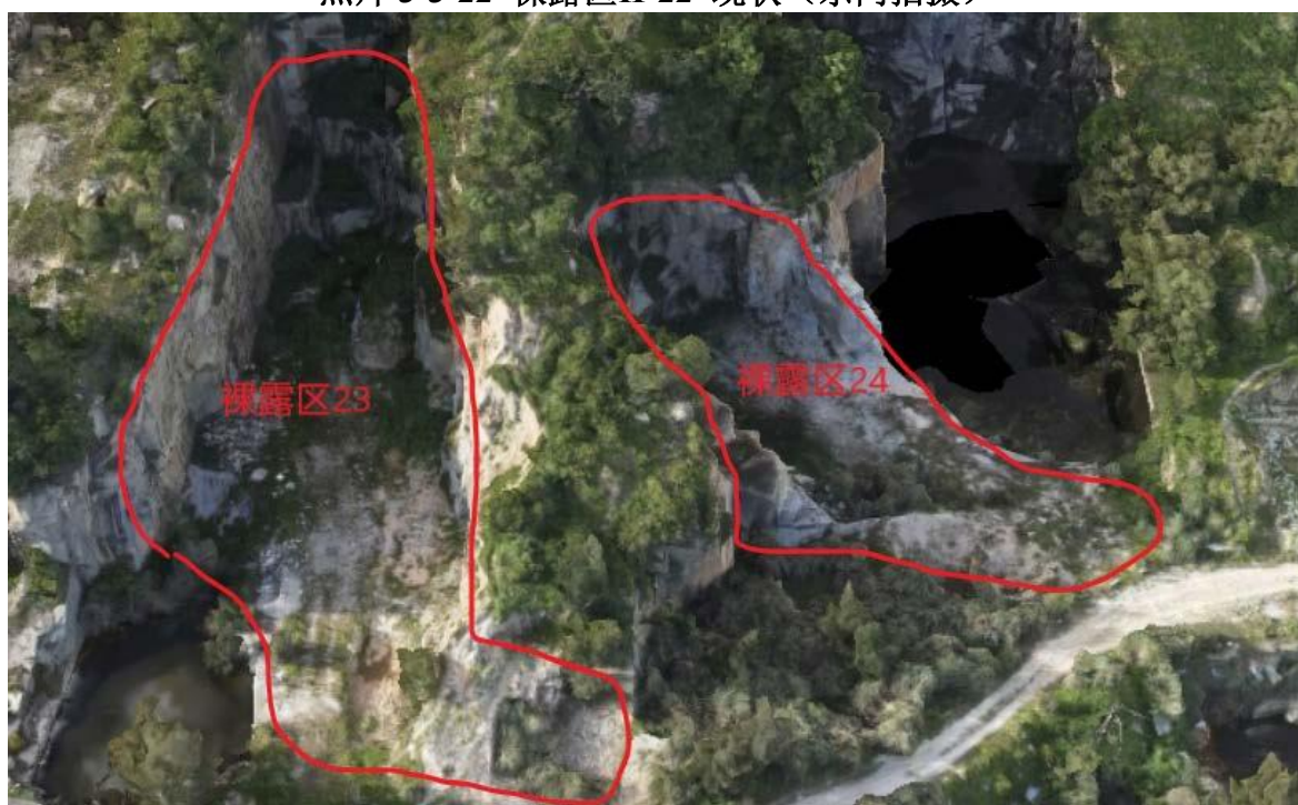
照片 3-3-23 裸露区II-23、II-24 现状（北向拍摄）
