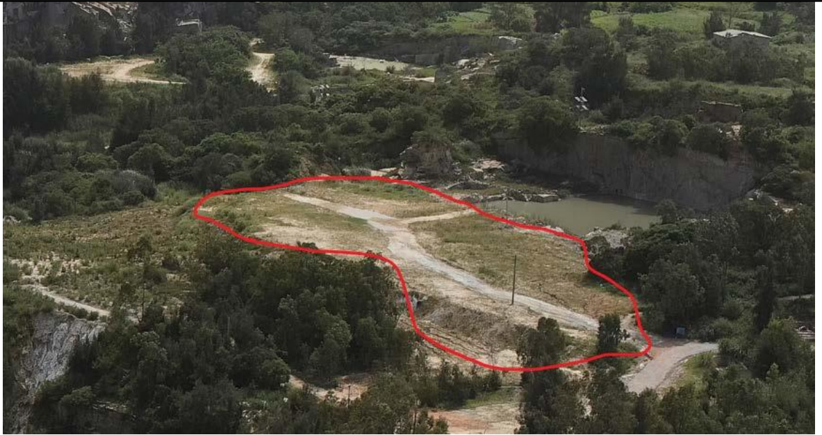
照片 3-3-24 裸露区II-25 现状（东北向拍摄）
