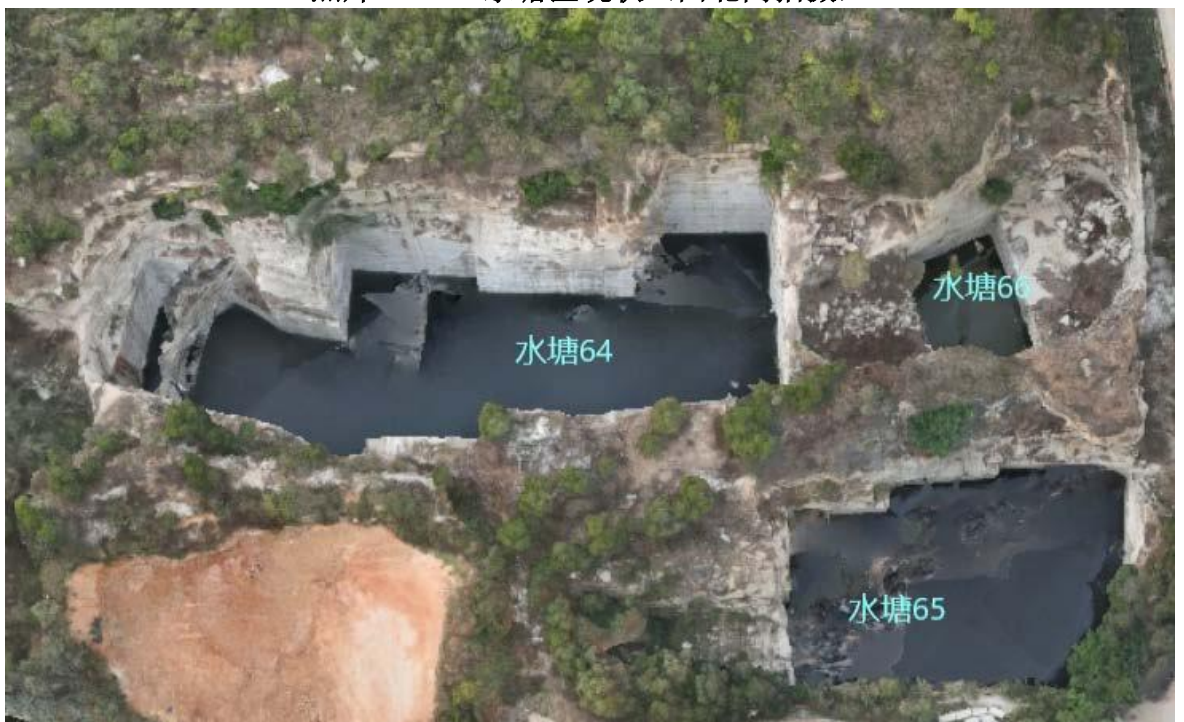
照片 3-5-46 水塘区现状（西北向拍摄）
