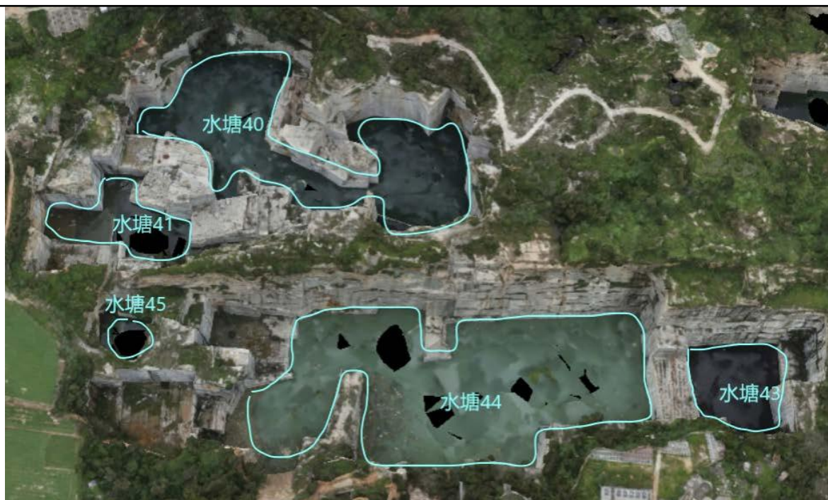
照片 3-4-28 水塘区现状（西北向拍摄）
