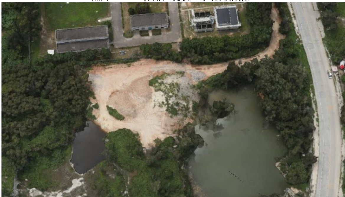
照片 3-5-41 裸露区II-50 现状（西北向拍摄）
